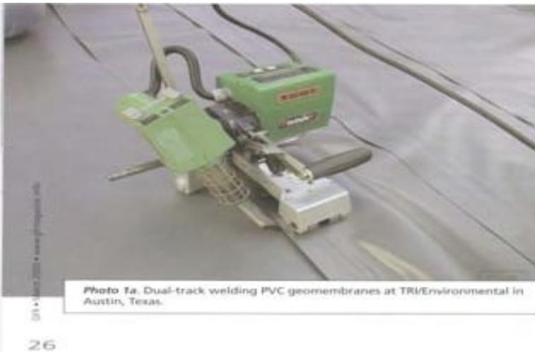
Fig. 2 - saldatura a doppia pista
