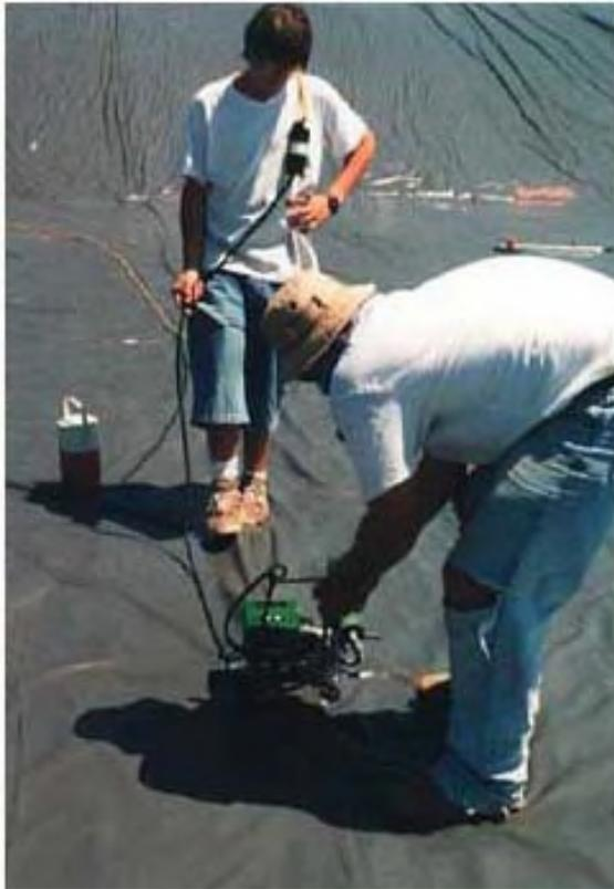
Fig. 1 – saldatura a caldo
