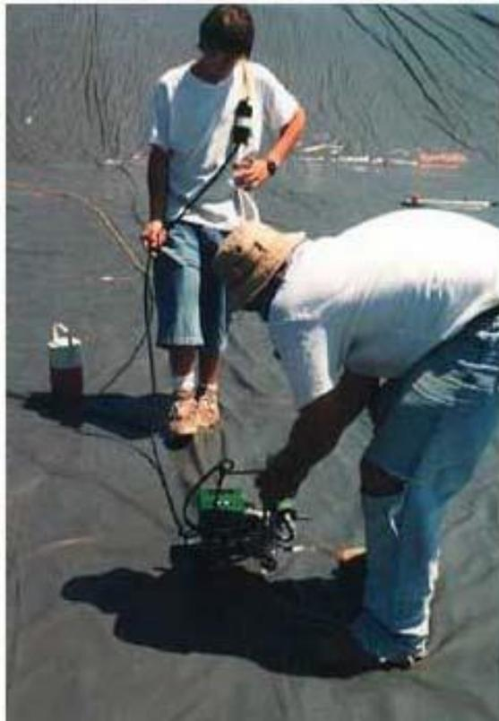
Fig. 1 – saldatura a caldo
