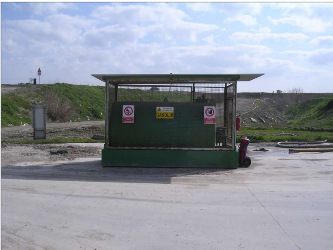
Serbatoio stoccaggio gasolio di servizio ai mezzi della discarica
