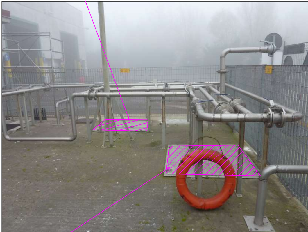
Vasca raccolta acque lavaggio area stabilizzazione e pozzetti
