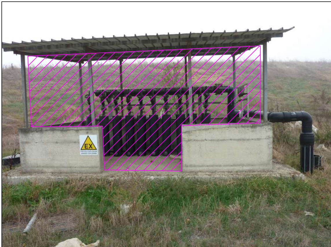
SOTTOSTAZIONE ARRIVO PRESE BIOGAS
